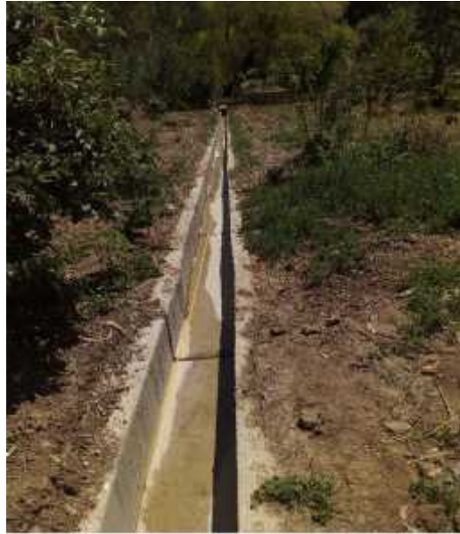
Vista fotográfica de los trabajos concluidos del tramo N° 03
