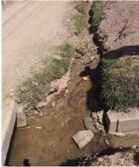
Vista del tramo N° 02 antes de la intervención
