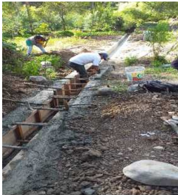
Vista fotográfica de los trabajos del tramo N° 03
