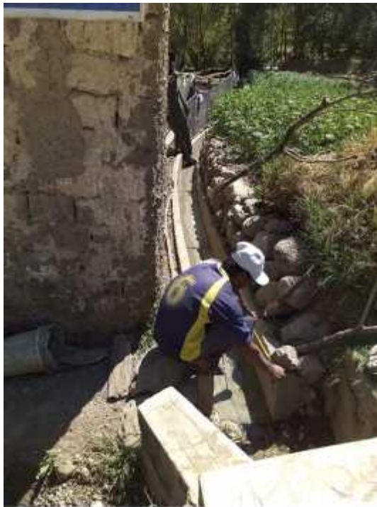
Vista de la medición final del tramo revestido concluido del tramo N° 01
