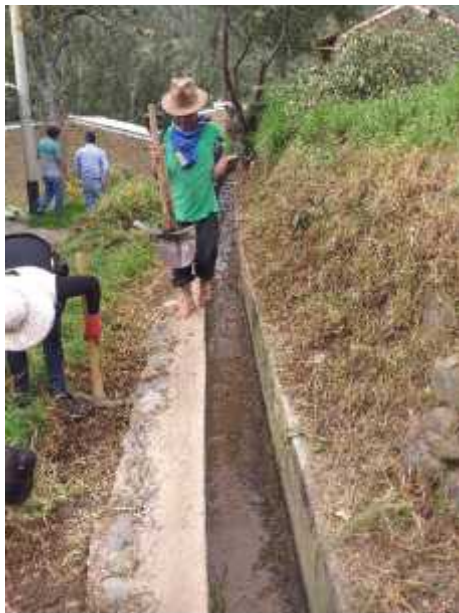
Limpieza de camino y franja del canal de riego
