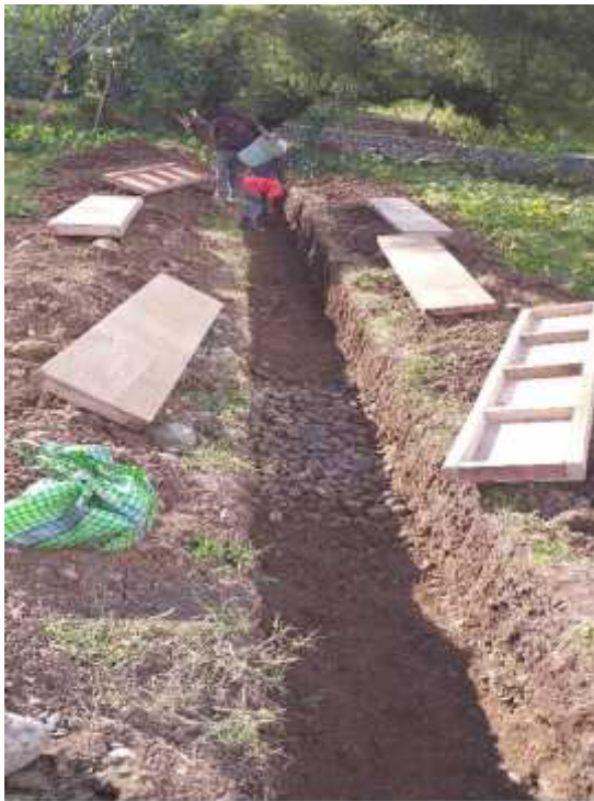
Vista fotográfica de los trabajos del tramo N° 03
