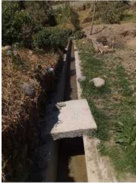
VISTA FOTOGRÁFICA DE LOS TRABAJOS EN EL TRAMO N° 03
