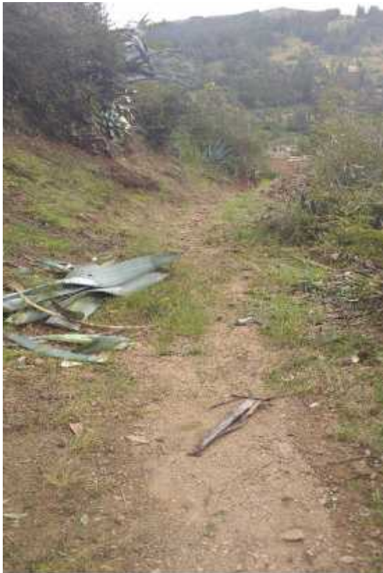
Limpieza y rehabilitación del camino rural hacia la zona de Laborpampa.
