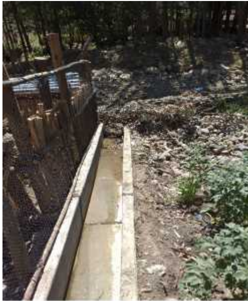
Vista del tramo de entrega final del tramo revestido concluido del tramo N° 01
