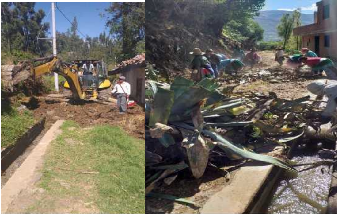
Limpieza y rehabilitación de caminos dentro de la zona urbana.
