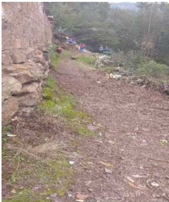
Limpieza y rehabilitación del camino sector cementerio
