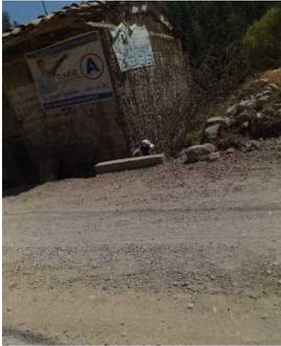
Vista del inicio del tramo N° 01
