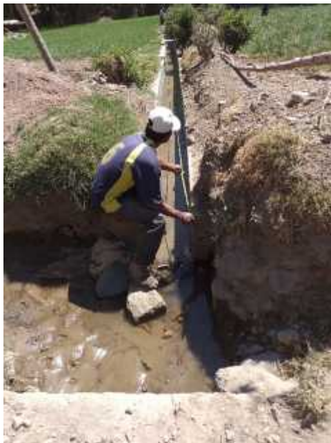
Vista de la medición final del tramo revestido concluido del tramo N° 02
